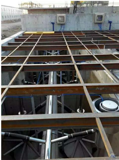
活性炭作为过滤滤料的水过滤处理工艺。 活性炭过滤，以活性炭为滤料进行水处理的过程。活性炭是一种经过气化(碳化、活化)造成发达孔隙的，以炭作骨架结构的黑色固体物质。它的发达孔隙使其具有很大的比表面积，每克材料的表面积为500~1700m<sup>2</sup>，从而具有良好的吸附特性。活性炭的真比重为1.9~2.1。 活性炭每克表面积为500-1700m<sup>2</sup>真比重为1.9-2.1。 过滤时由于其多孔性可吸附各种液体中的微细物质，常用于水处理中的脱色、脱臭、脱氯、去除有机物及重金属、去除合成洗涤剂、细菌、病毒及放射性等污染物质，也常用于废水的三级处理。 活性炭过滤器分固定床、移动床及流动床三种类型。固定床滤速一般采用8-20m/h活性炭用高温水蒸气清洗再生或热再生，回收率可达80-94%。江苏机械过滤器哪家好自动过滤精度默认为100微米。
